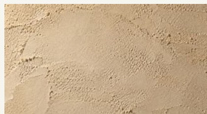
Enduit à la chaux
